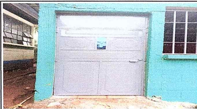
Foto 3: Culminación de la reparación de la cocina de la escuela
