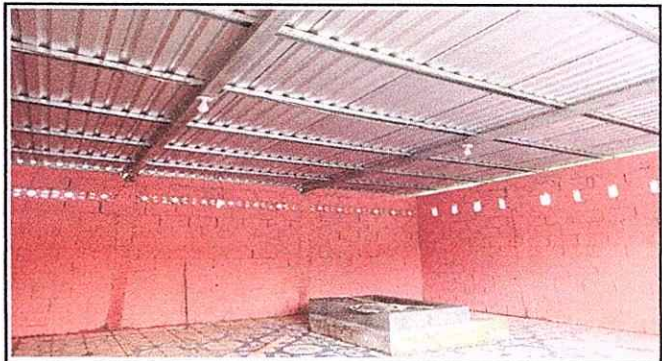
Foto 2: Culminación de la reparación del techo de la cocina
