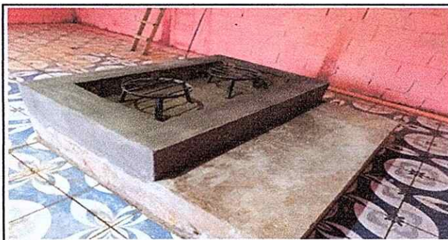
Foto 5: Culminación de la reparación del polleton de la cocina
