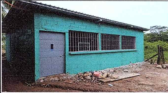
Foto 1: Culminación de la reparación de la estructura de la cocina
