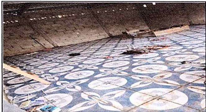
Foto 4: Culminación de la reparación del piso de la cocina
